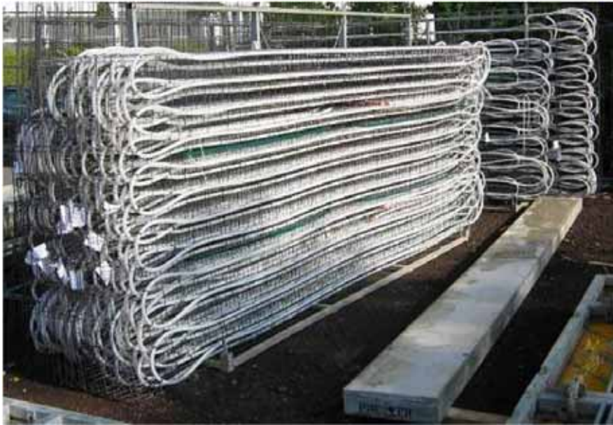
Abbildung C-06 Rohrregister von TABS (FRIES 2009).
